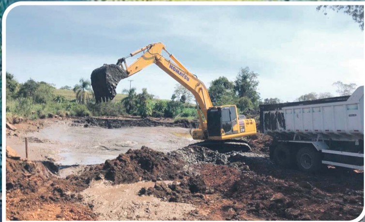
Dois retroscavadeiras adquiridas no valor de R$905.000,00
